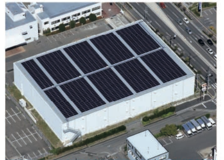
長野県 株式会社NTTロジスコ B棟 設置量:318.6kW
