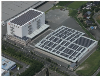
佐賀県 三菱倉庫株式会社 鳥栖営業所 設置量:777.2kW
