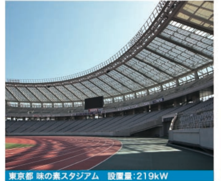
東京都 味の素スタジアム 設置量:219kW
