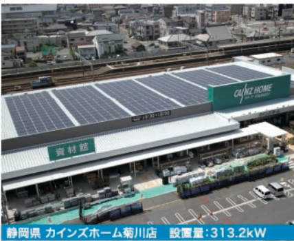
静岡県 カインズホーム菊川店 設置量:313.2kW
