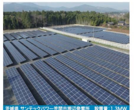
茨城県 サンテックパワー-笠間市押辺発電所 設置量:1.3MW
