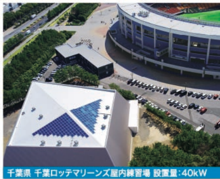
千葉県 千葉ロッテマリーンズ屋内練習場 設置量:40kW
