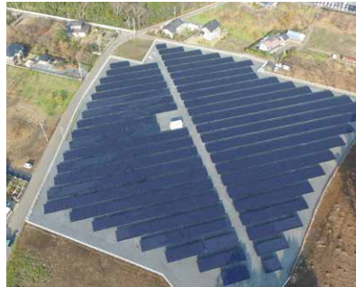
■ 水戸市小林町太陽光発電所
