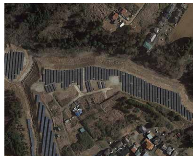
■ 千葉緑区太陽光発電所
